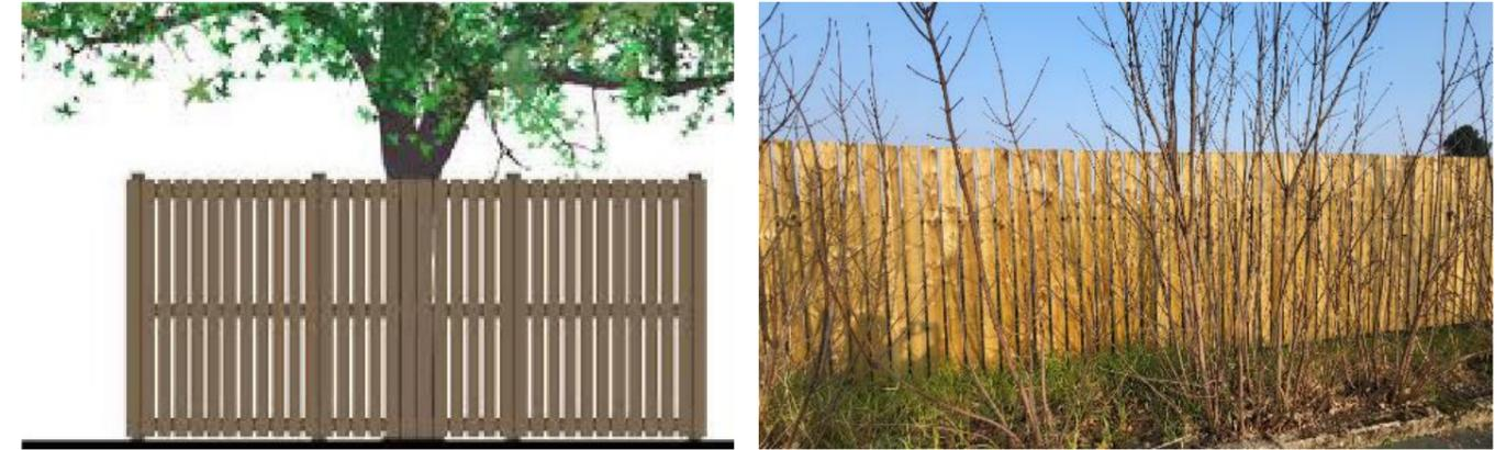
Figure 10 : Dispositifs de conservation et de palissage en phase travaux, source : Graphyte
